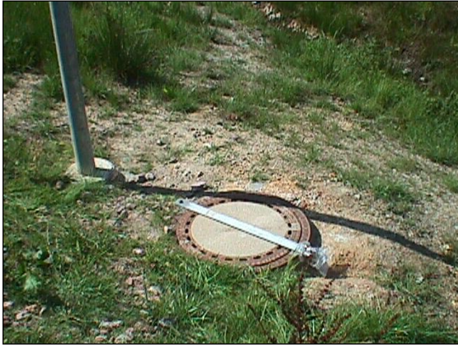
Bild 21 Abdeckung zu dem Brunnen, in den die Kolonnen eingebaut werden
